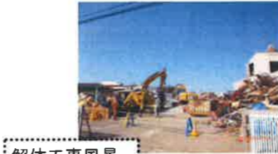
解体工事風景。
