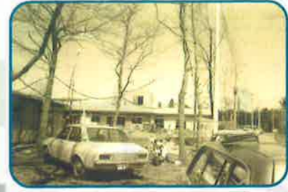
建設中の様子
