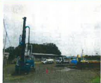
地中にコンクリートを流し込む工事を行っています。(H25年9月撮影)
